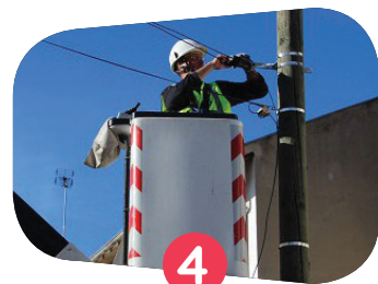
4 Étude des supports aériens et des façades
