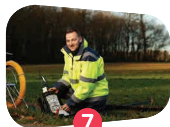
7 Tirage de câble
