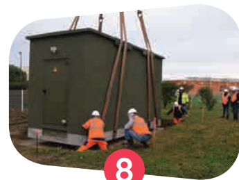
8 Installation des locaux techniques
