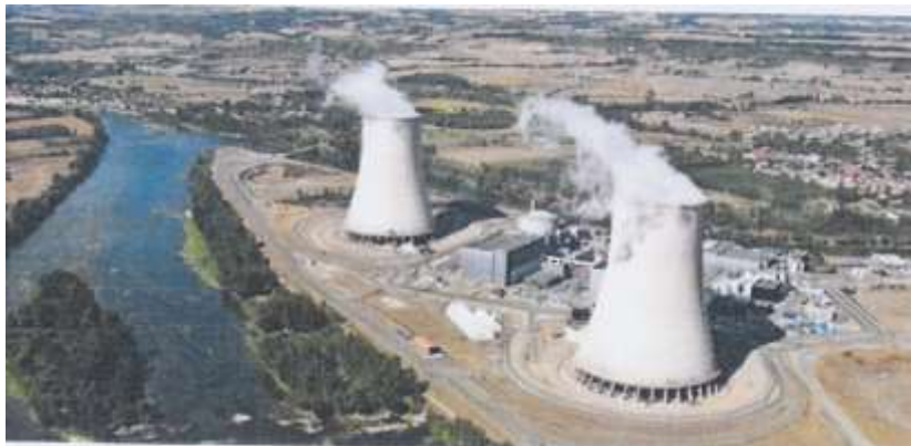
Centrale de Golfech
